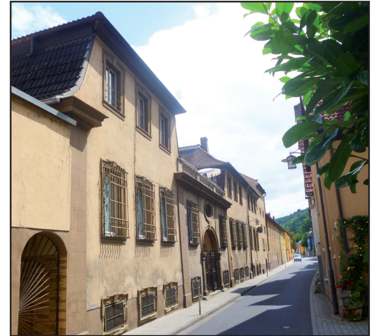
Die Westfassade des von Balthasar Neumann 1744 für Andreas Wiesen errichteten Palais in der Hauptstraße 18
