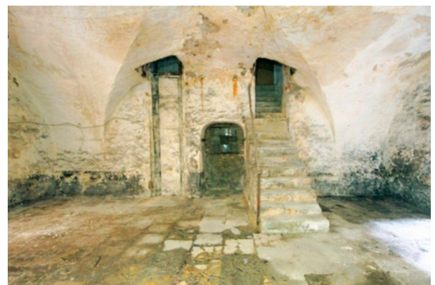
Zentralkeller (Foto: Christian Naser)
