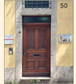
Türblatt u. Portal (bauzeitlich)
