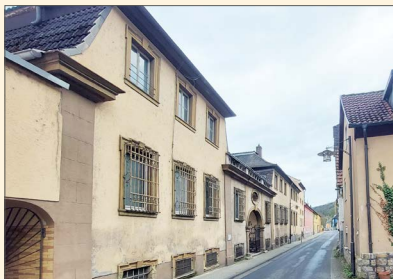
Ansicht von der Hauptstraße
