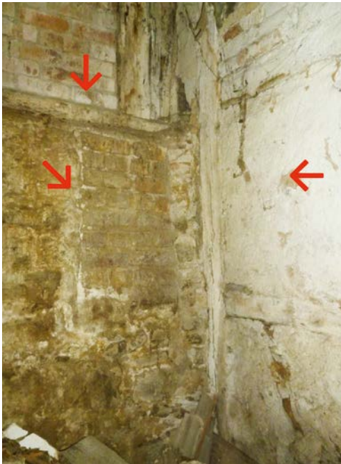
Abb. 21: Südwand mit der östlichen Hälfte des Kellereingangs ↘. Spätestens durch die Errichtung der Fachwerkmauer ← wurde er unbenutzbar. Die Schwelle ↓ liegt circa 1,5 Meter unter dem Bodenniveau der Südgasse.
