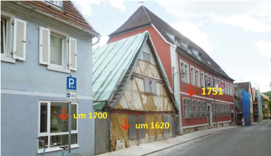
Abb. 27: Die unterschiedlichen Höhenniveaus der Fenster und Stockwerksgesimse
