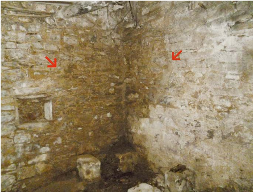
Abb. 25: Südwestecke mit auffallender Veränderung von Steinformat und Mörtel ↘↙
