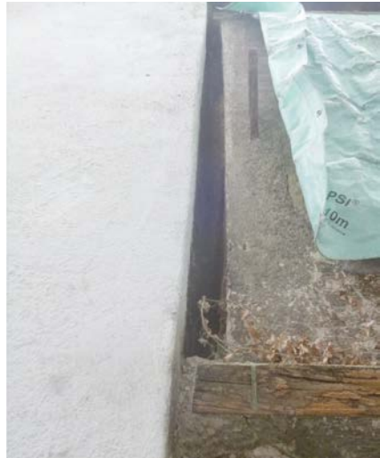
Abb. 6: „Baufuge“ und gekappter Schwellbalken zwischen den Gebäuden
