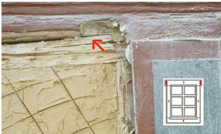
Abb. 15: Die Aussparungen an der Schwelle im oberen Fensterbereich geben den Hinweis auf den Aufbau der geohrten Fensterrahmen ↖
