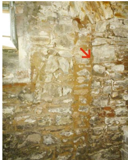
Abb. 20: Nordwand, zugesetzte Tür zur Nordgasse Der Pfeil markiert das jetzige Bodenniveau der Gasse ↘
