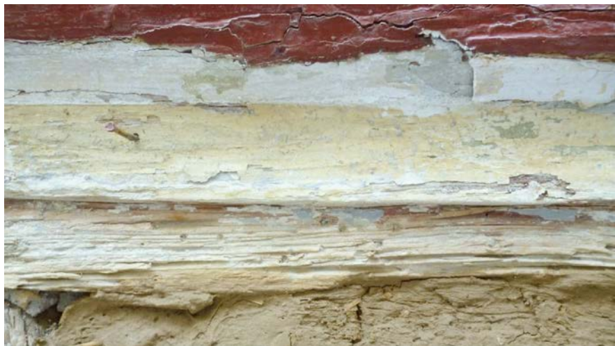
Abb. 16: verschiedene Farbfassungen am reich profilierten Rähmbalken
