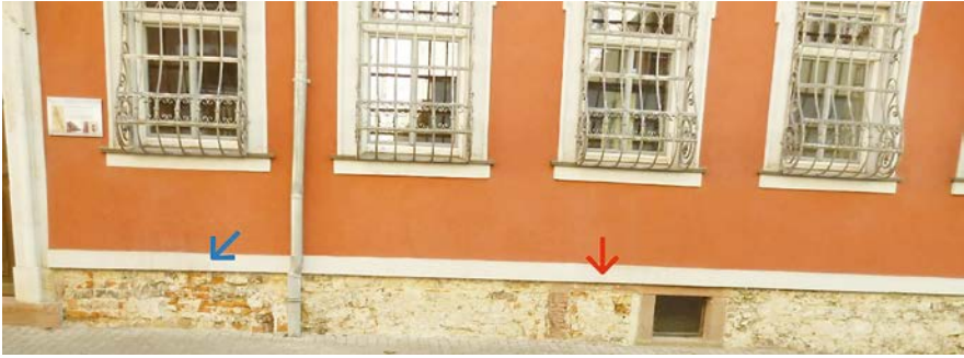
Abb. 11: Ein zugesetztes Kellerfenster des Vorgängerbaus ↓ Links von der Dachrinne kommt es bis zum nördlichen Gebäudeende zu einem auffallenden Materialwechsel aus Backsteinen und schiefbrigem, bläulichem Muschelkalk ↙.
