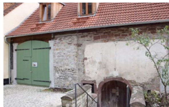
Die Marktgemeinde sanierte mit Unterstützung des AK WAG die historische Scheune am Kelterhof
